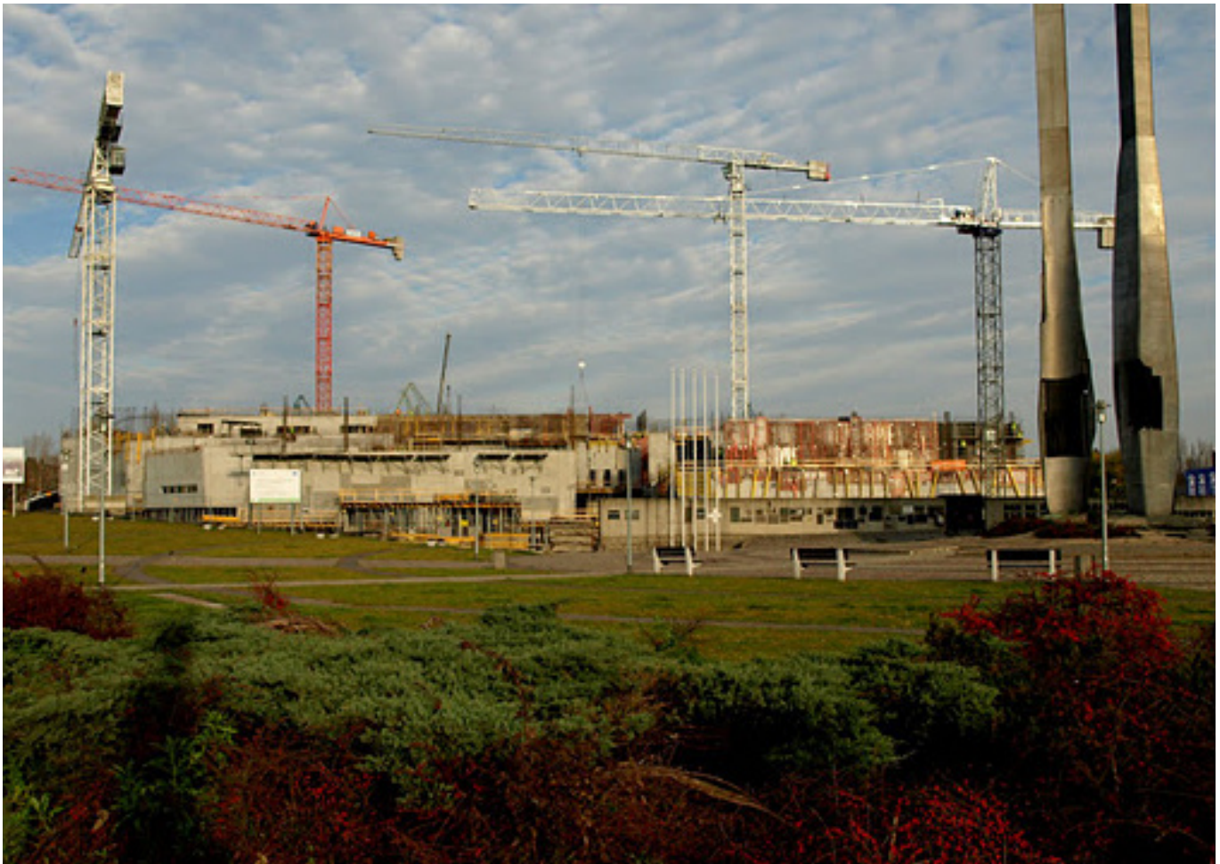
Europejskie Centrum Solidarności w budowie
